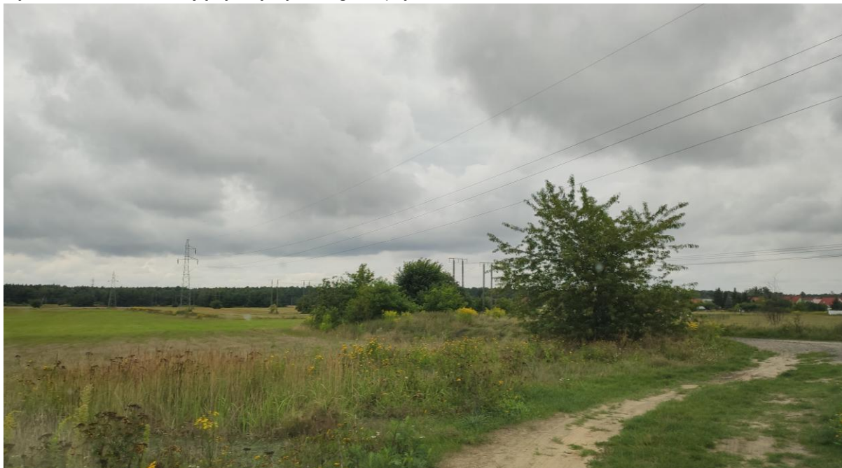
Ryc. 5. Widok na istniejącą linię wysokiego napięcia 110 kV
