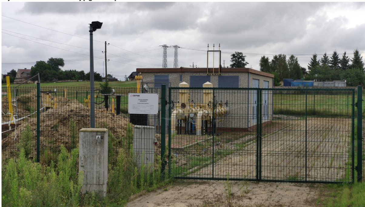
Ryc. 6. Widok na stację gazową
