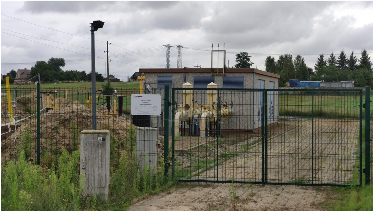
Ryc. 6. Widok na stację gazową
