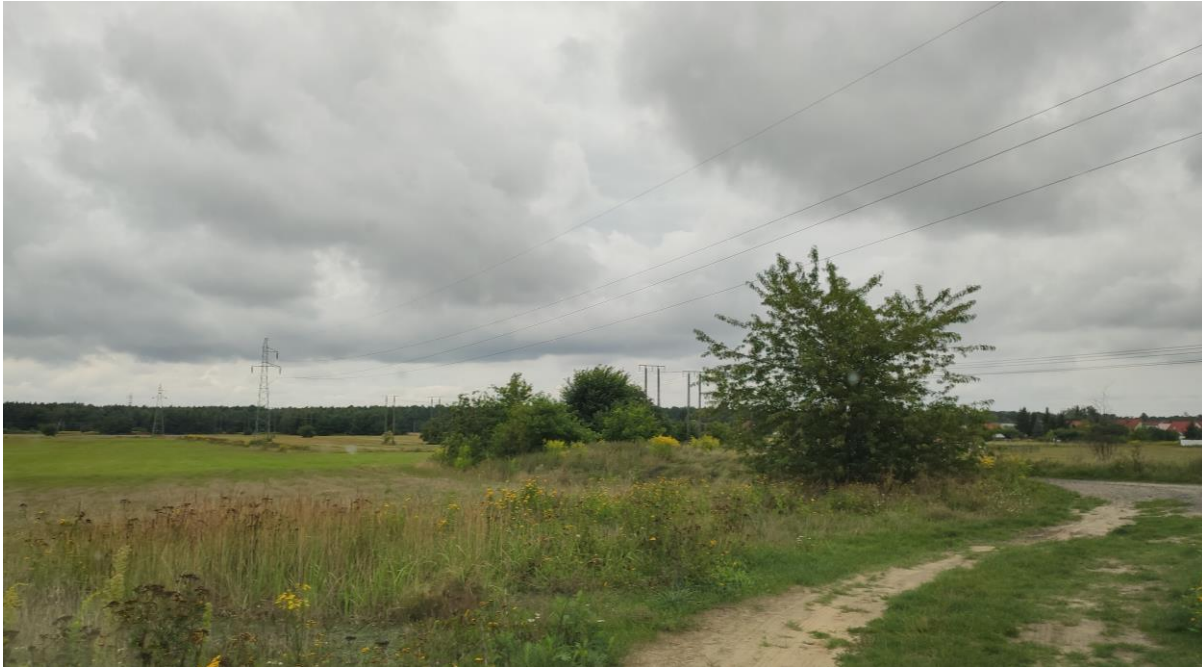
Ryc. 5. Widok na istniejącą linię wysokiego napięcia 110 kV
