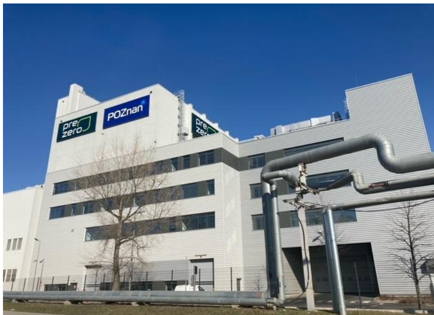
Rysunek 1 Instalacja Termicznego Przekształcania Odpadów Komunalnych (ITPOK)
