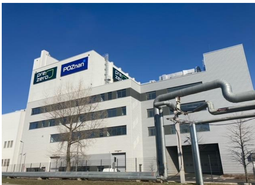
Rysunek 1 Instalacja Termicznego Przekształcania Odpadów Komunalnych (ITPOK)
