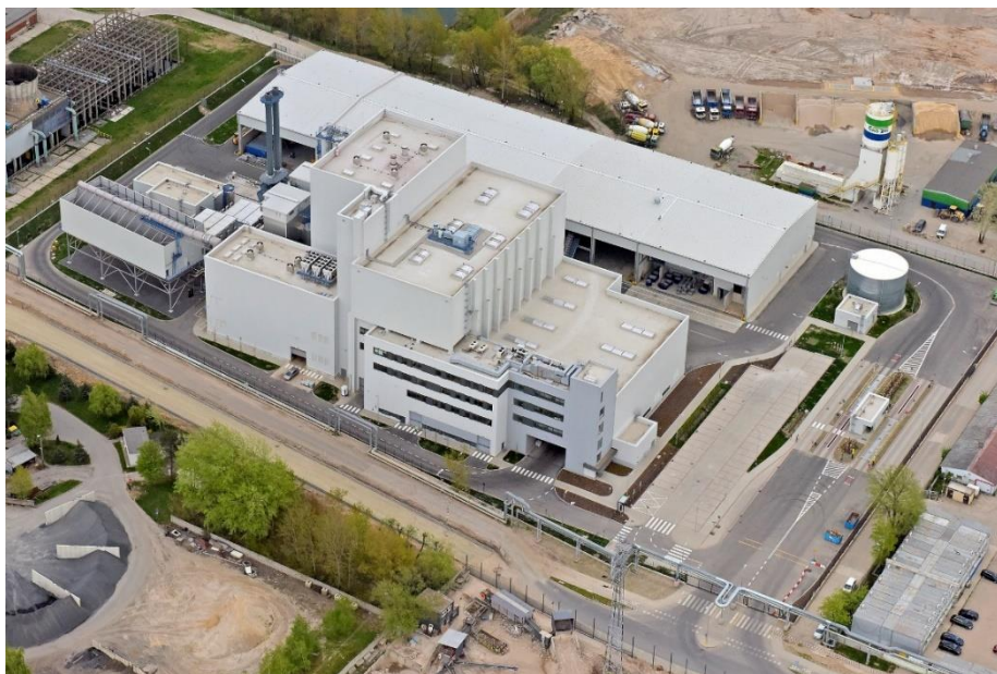
Rysunek 2 Instalacja Termicznego Przekształcania Odpadów Komunalnych (ITPOK) z góry
