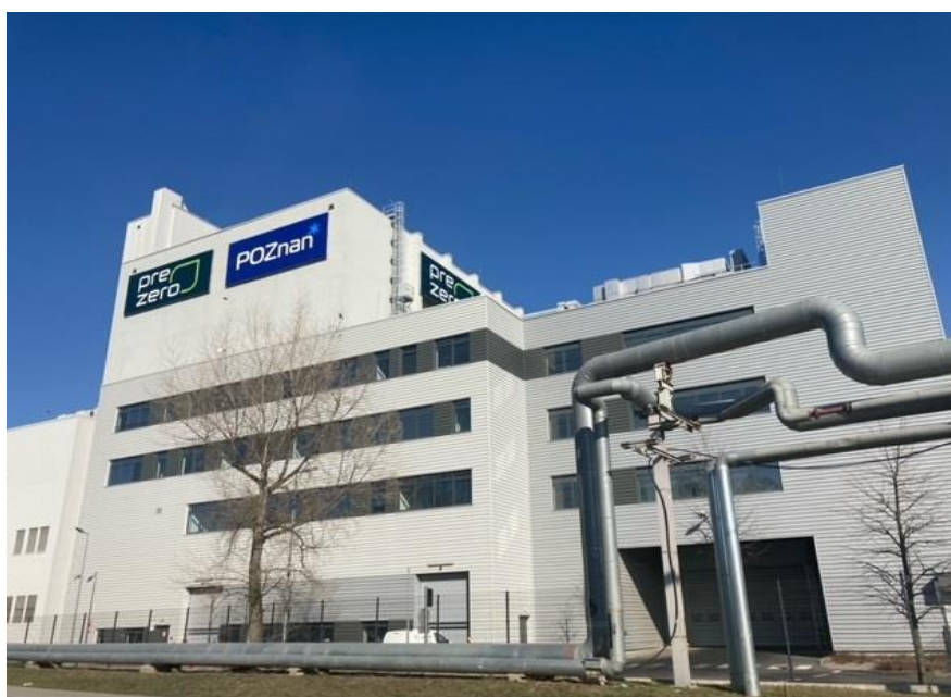
Rysunek 1 Instalacja Termicznego Przekształcania Odpadów Komunalnych (ITPOK)
